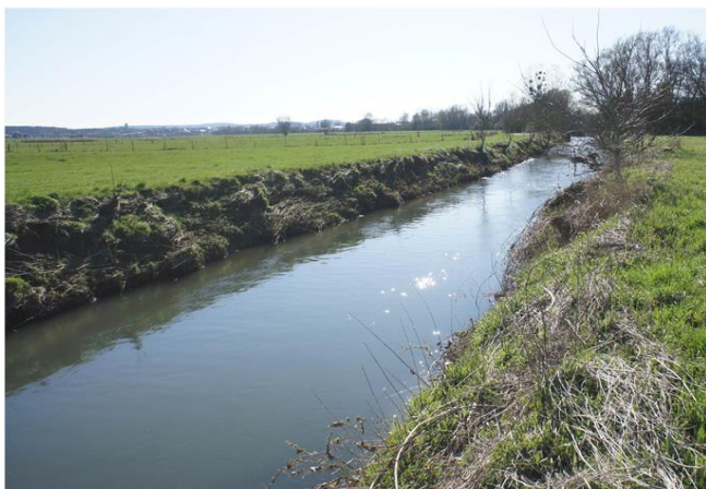
Foto gegen Fließrichtung
