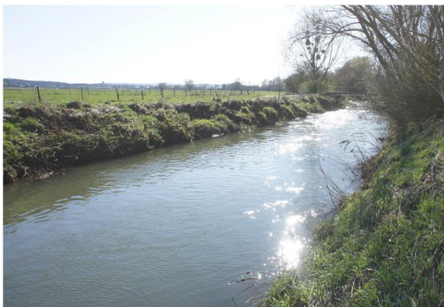
Foto gegen Fließrichtung
