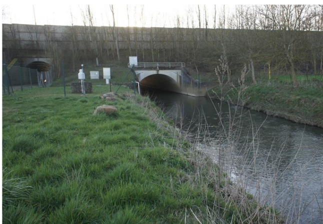
Foto gegen Fließrichtung
