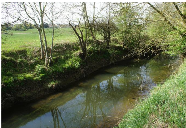
Foto gegen Fließrichtung
