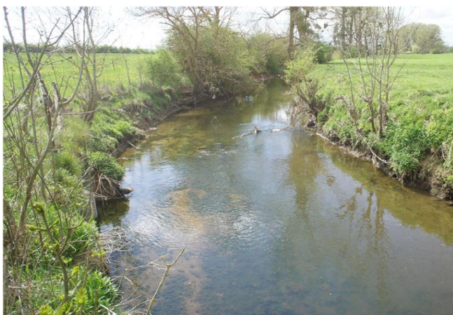
Foto gegen Fließrichtung
