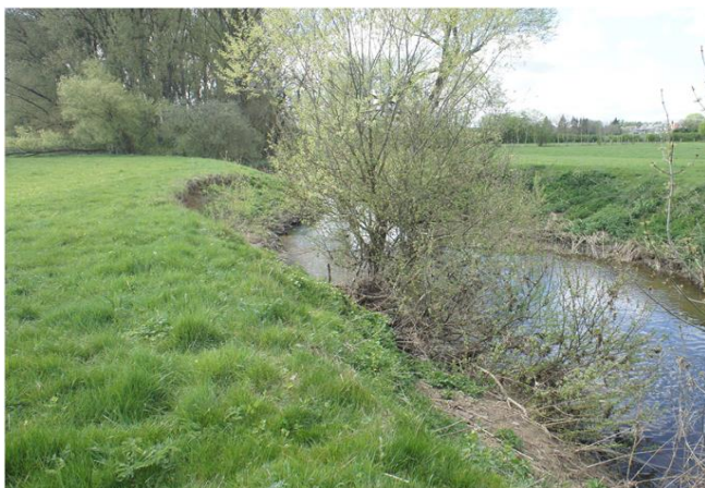
Foto gegen Fließrichtung
