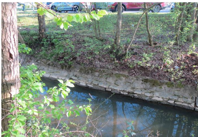
Foto gegen Fließrichtung
