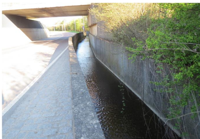
Foto gegen Fließrichtung
