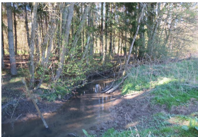
Foto gegen Fließrichtung
