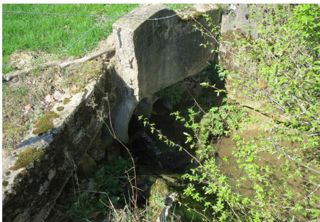
Foto gegen Fließrichtung
