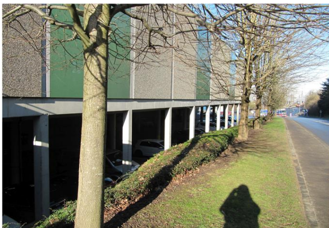
Foto gegen Fließrichtung
