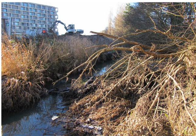
Foto gegen Fließrichtung
