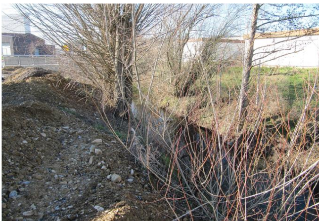
Foto gegen Fließrichtung
