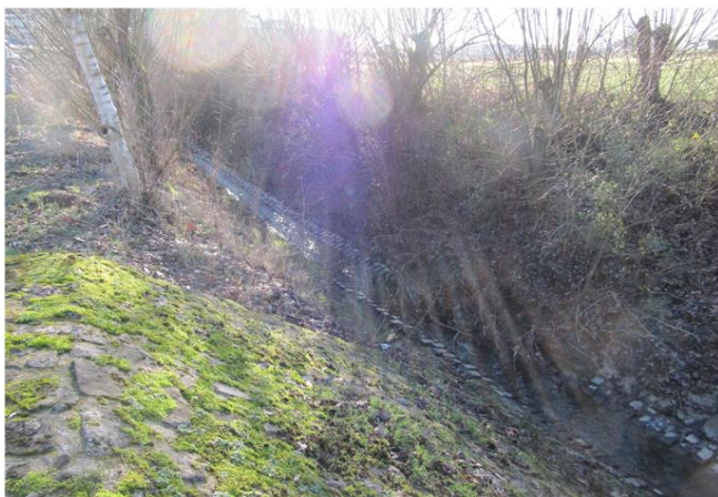
Foto gegen Fließrichtung
