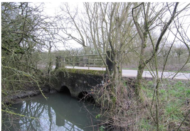
Foto gegen Fließrichtung
