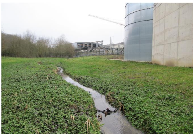
Foto gegen Fließrichtung
