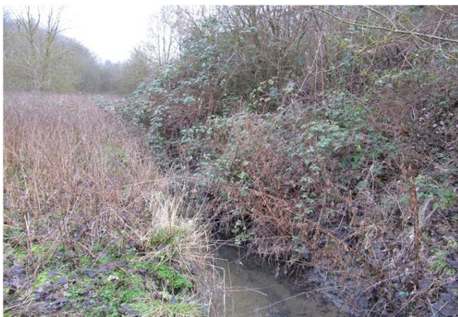
Foto gegen Fließrichtung
