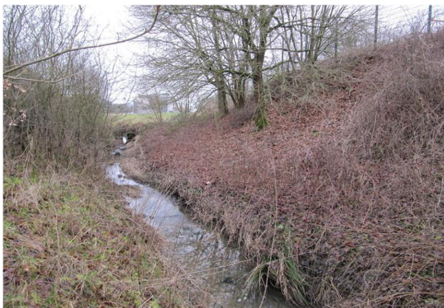
Foto gegen Fließrichtung
