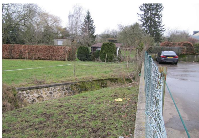
Foto gegen Fließrichtung
