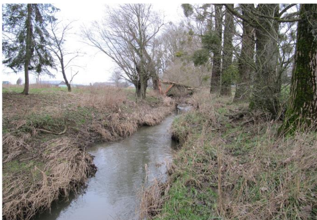
Foto gegen Fließrichtung
