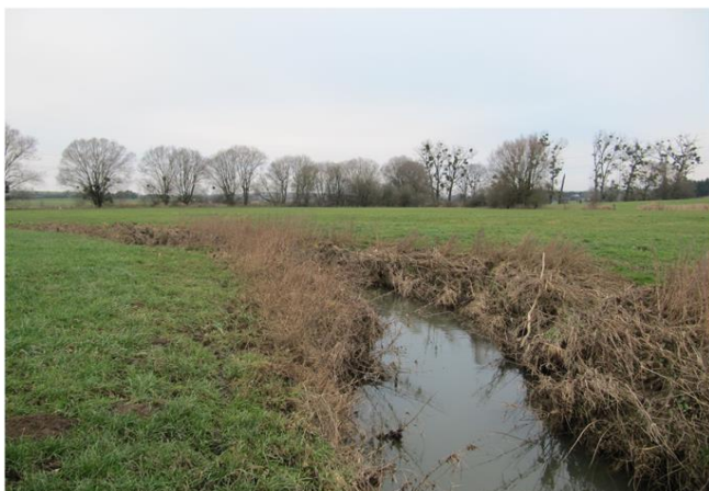
Foto gegen Fließrichtung
