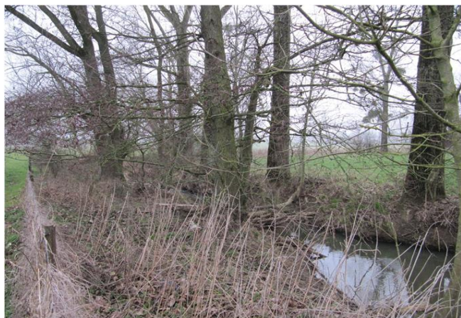
Foto gegen Fließrichtung
