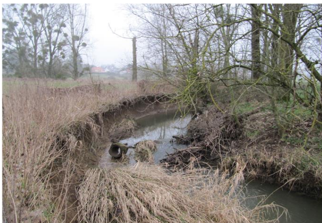
Foto gegen Fließrichtung
