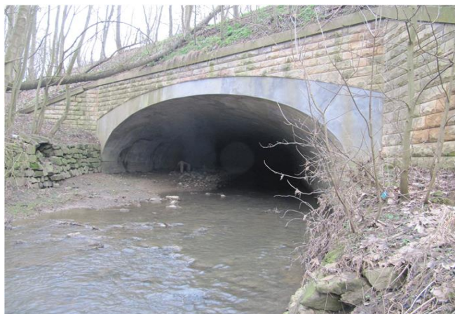
Foto gegen Fließrichtung
