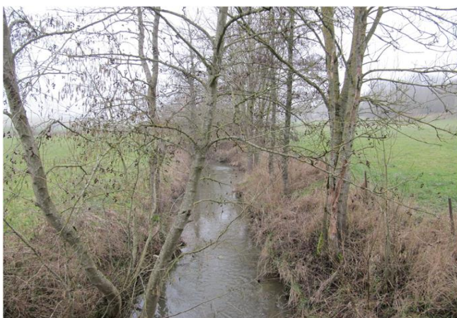
Foto gegen Fließrichtung
