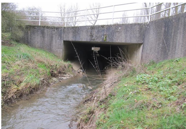
Foto gegen Fließrichtung
