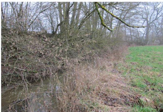
Foto gegen Fließrichtung
