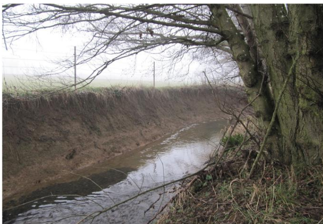
Foto gegen Fließrichtung
