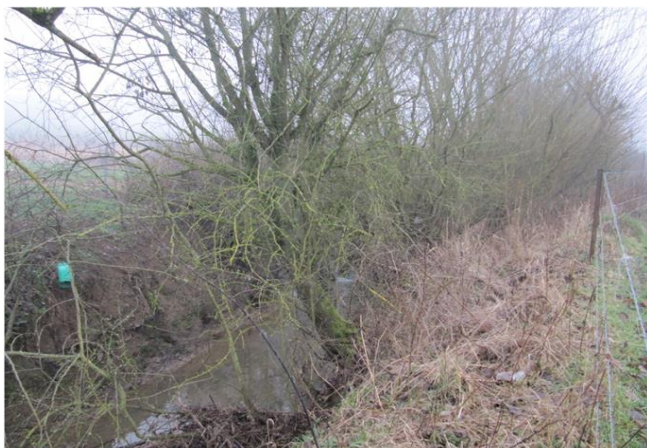
Foto gegen Fließrichtung
