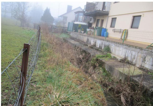
Foto gegen Fließrichtung
