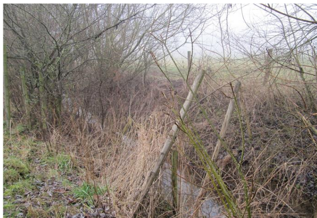
Foto gegen Fließrichtung
