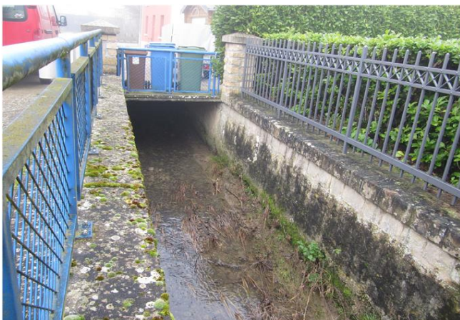
Foto gegen Fließrichtung
