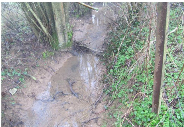
Foto gegen Fließrichtung
