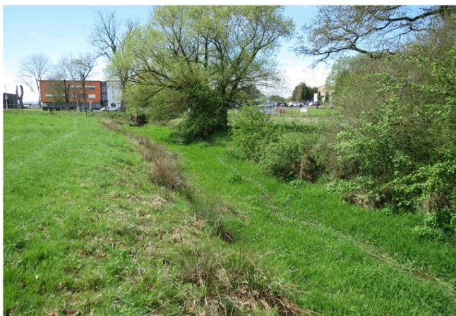
Foto gegen Fließrichtung
