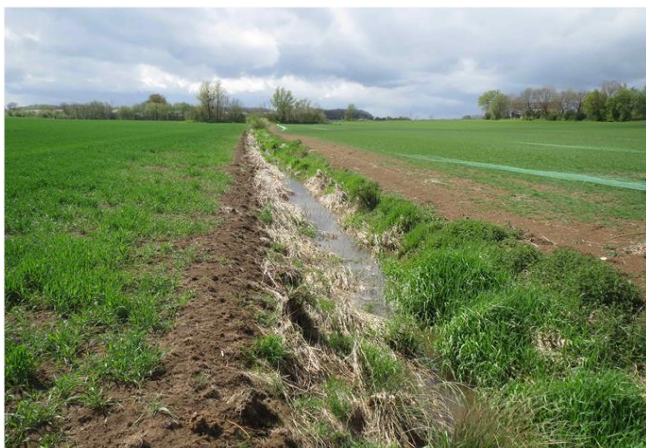
Foto gegen Fließrichtung
