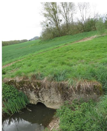
Foto gegen Fließrichtung
