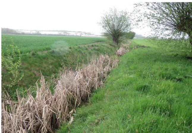
Foto gegen Fließrichtung
