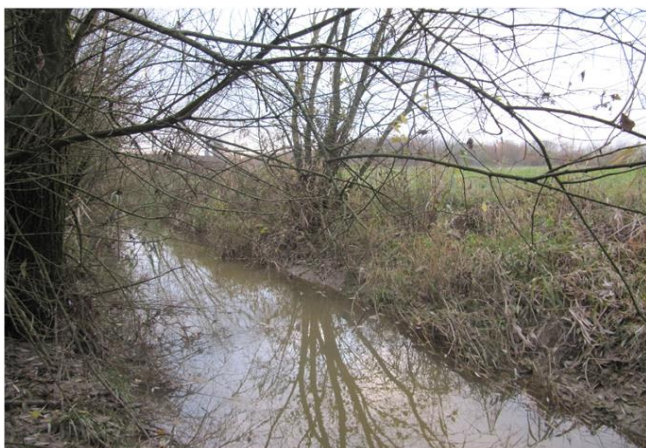
Foto gegen Fließrichtung
