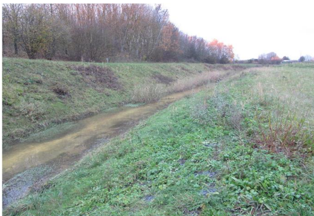
Foto gegen Fließrichtung
