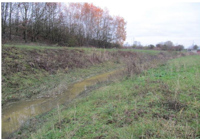
Foto gegen Fließrichtung
