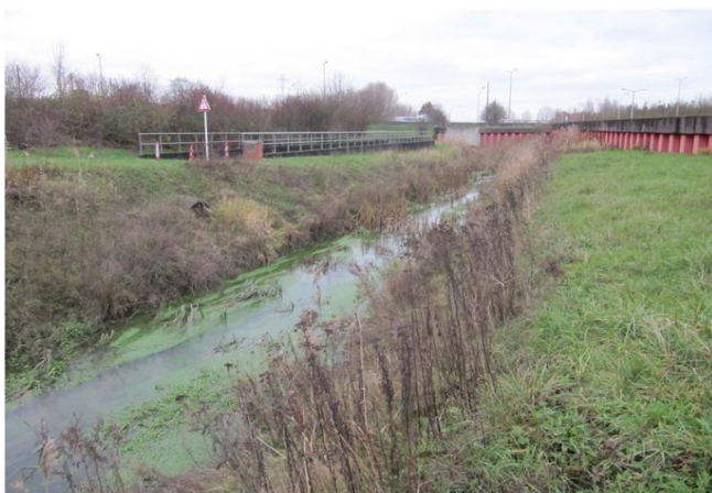
Foto gegen Fließrichtung
