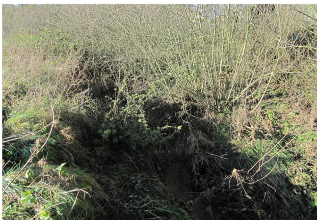
Foto gegen Fließrichtung
