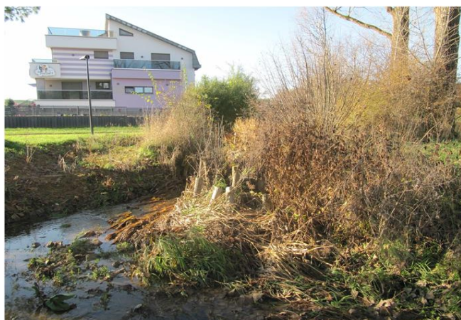
Foto gegen Fließrichtung
