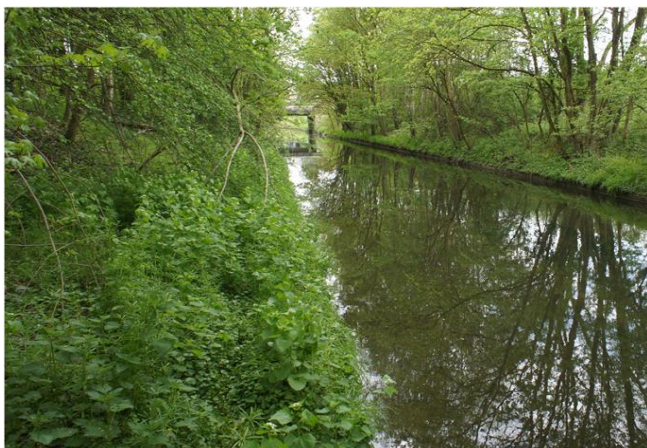
Foto gegen Fließrichtung
