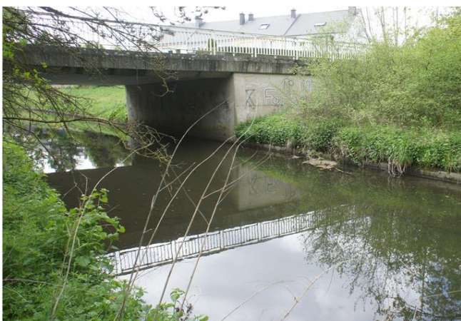
Foto gegen Fließrichtung
