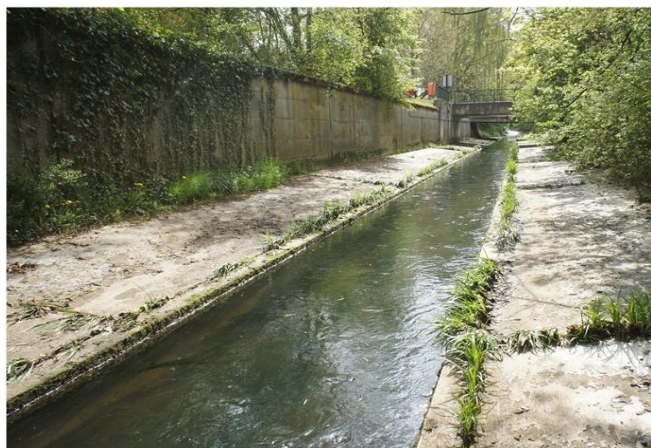
Foto gegen Fließrichtung
