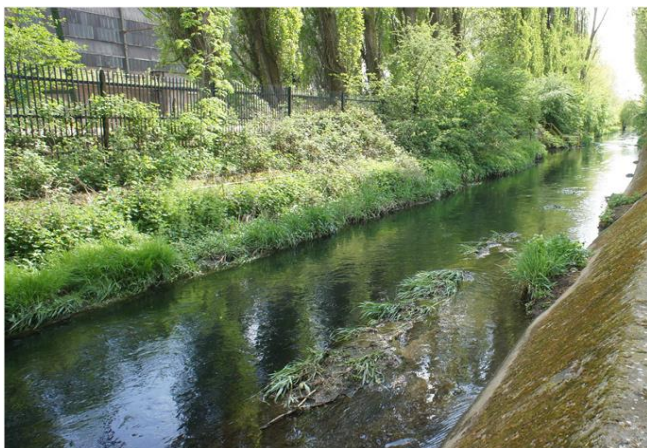
Foto gegen Fließrichtung
