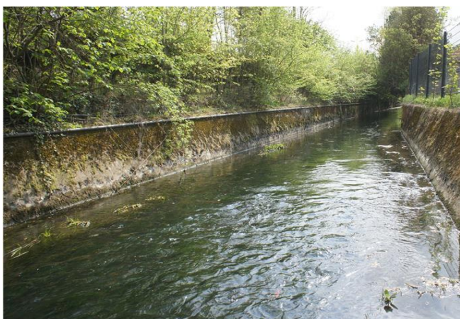
Foto gegen Fließrichtung
