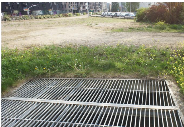
Foto gegen Fließrichtung
