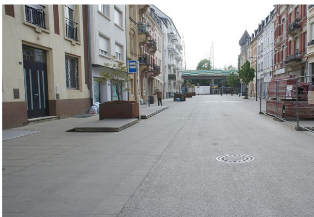
Foto gegen Fließrichtung
